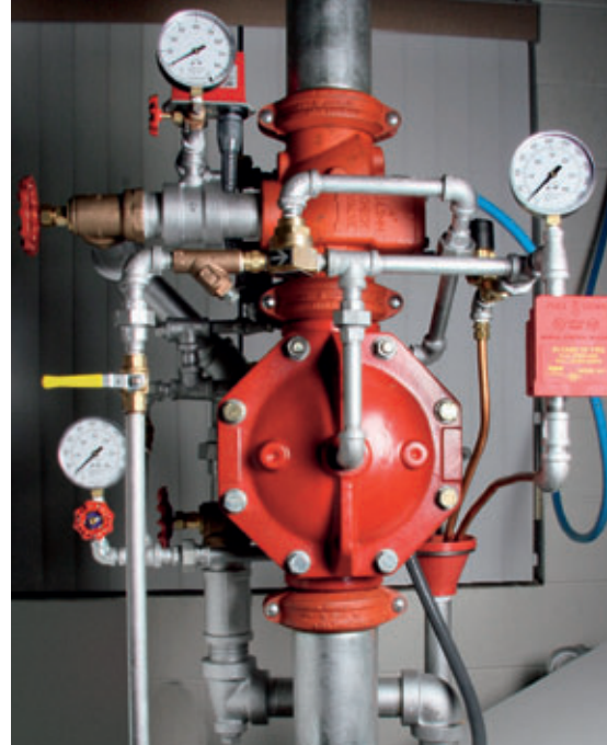
Клапан DV-5 системы предварительного действия
