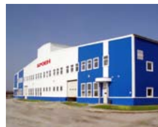
Производственный комплекс BROEN в Коломне
