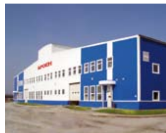
Производственный комплекс BROEN в Коломне
